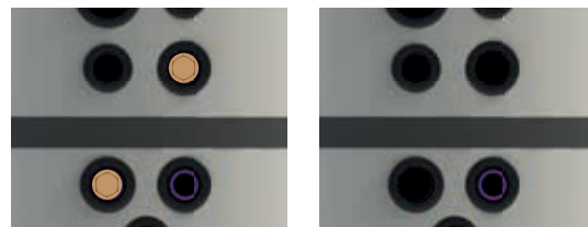
Bild 7: Die nicht benötigten Anschlüsse sind mit Vliesstopfen gedämmt, mit Steckrosetten (offen und blind) bzw. Abdeckhaube verschlossen.
