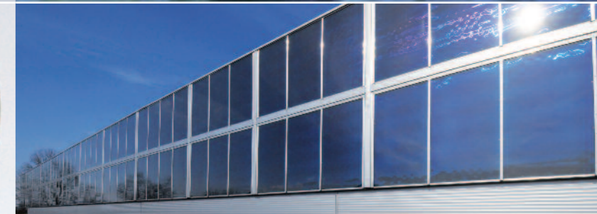
Chez Forstner, les bureaux et la production sont exclusivement chauffés avec des énergies renouvelables (252 m 2 de surface solaire fournissent entre 300 - 400 kWh/jour, y compris en hiver).
