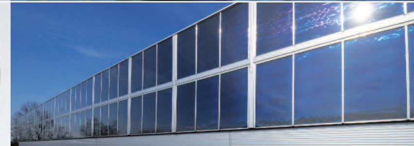
Büro u. Fertigung werden bei Forstner Speichertechnik GmbH ausschließlich mit erneuerbaren Energien versorgt (252 m² Solarfläche liefern auch im Winter zwischen 300 - 400 kWh/Tag).
