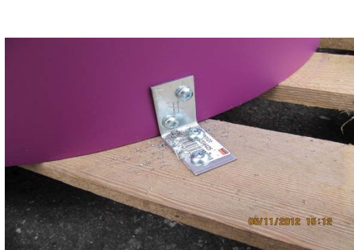
Frionic Speicher DM 850 mm wird mit je 2 Holz- und 2 Blechschrauben mit EWP formstabil verschraubt
