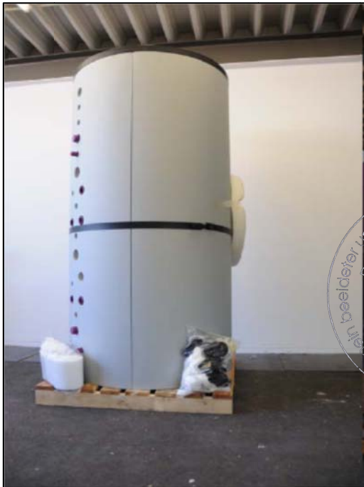
Anbringung Dämmung und Zubehör, Fixierung mit Spannbändern und oberer Abschluss durch Montage Deckelfolie
