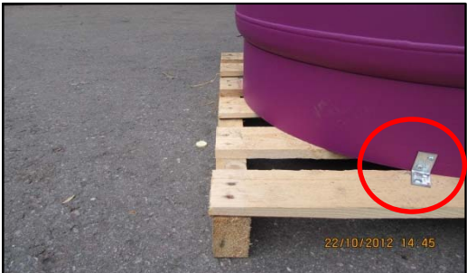
Speicher DM 850 mm wird mit je 2 Holz- und 2 Blechschrauben mit EWP formstabil verschraubt
